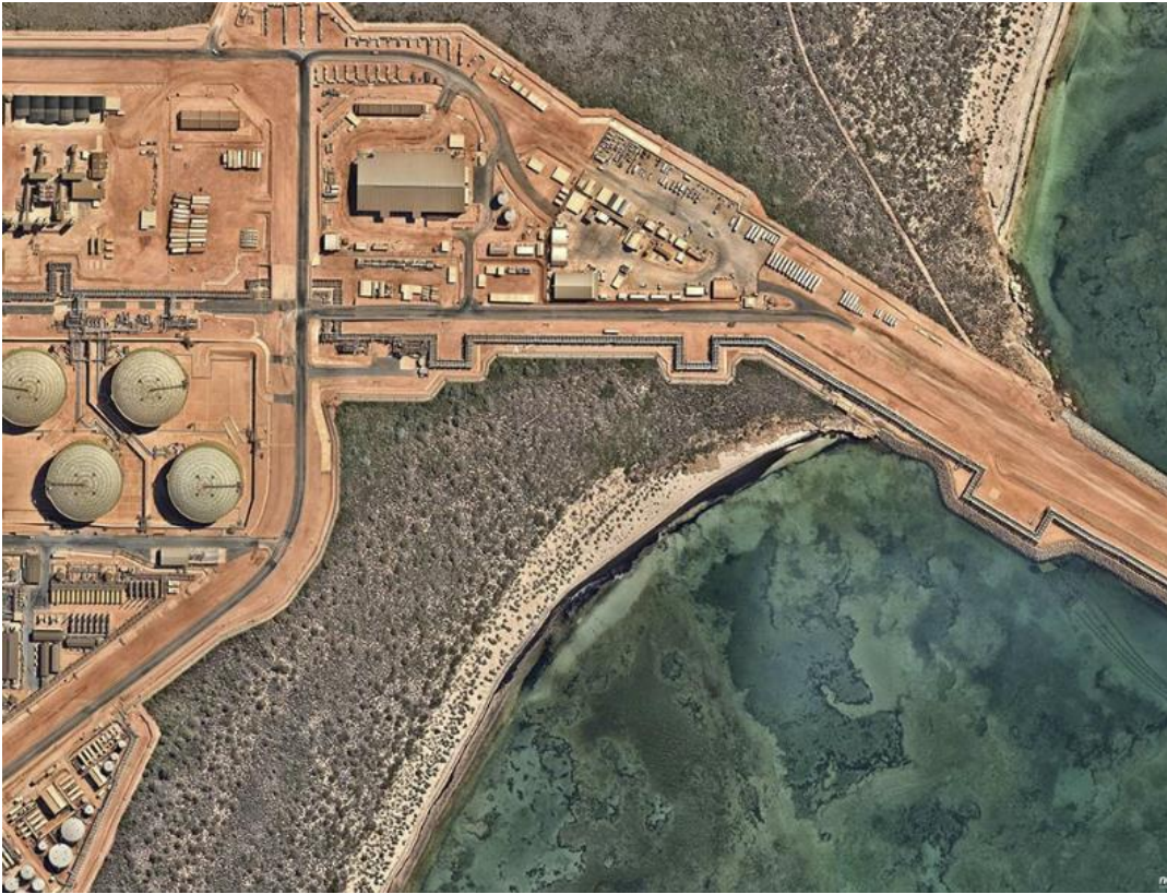
Photo 14: Gorgon LNG Plant, Barrow Island, WA
